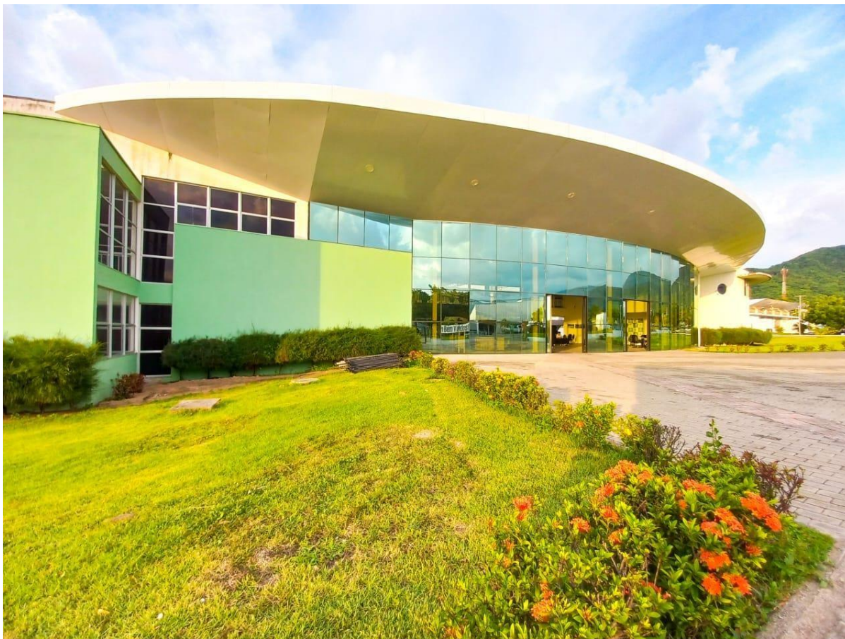
Figura 3 - Entrada principal do Prédio do IFCE - Itapipoca
