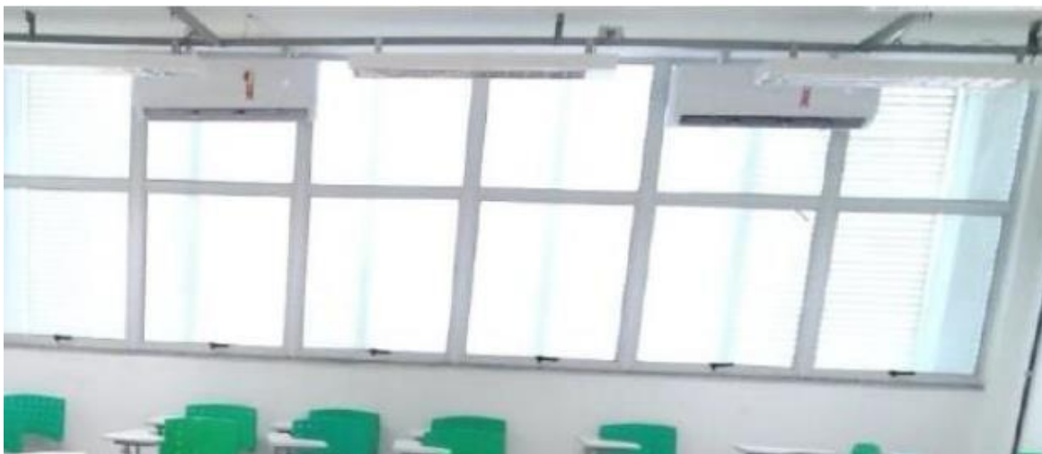
Figura 21 - Chegada dos ares-condicionados nas salas
