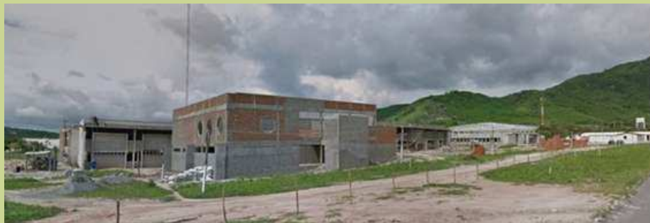
Prédio em construção
