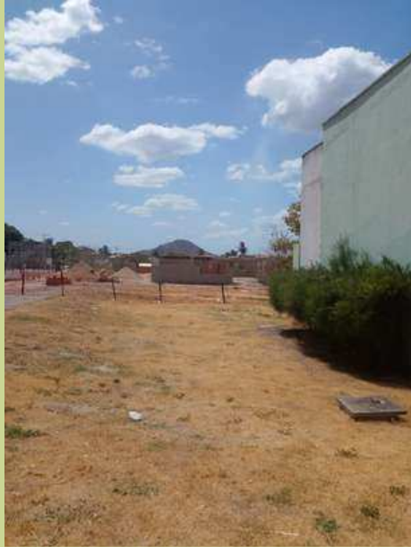
Legenda: Construção do refeitório. Foto: Andréa de Sousa, 2024.
