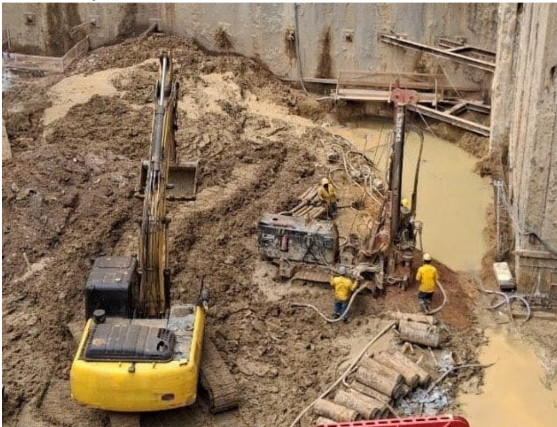
Figura 4 — Execução Estaca Raíz.
