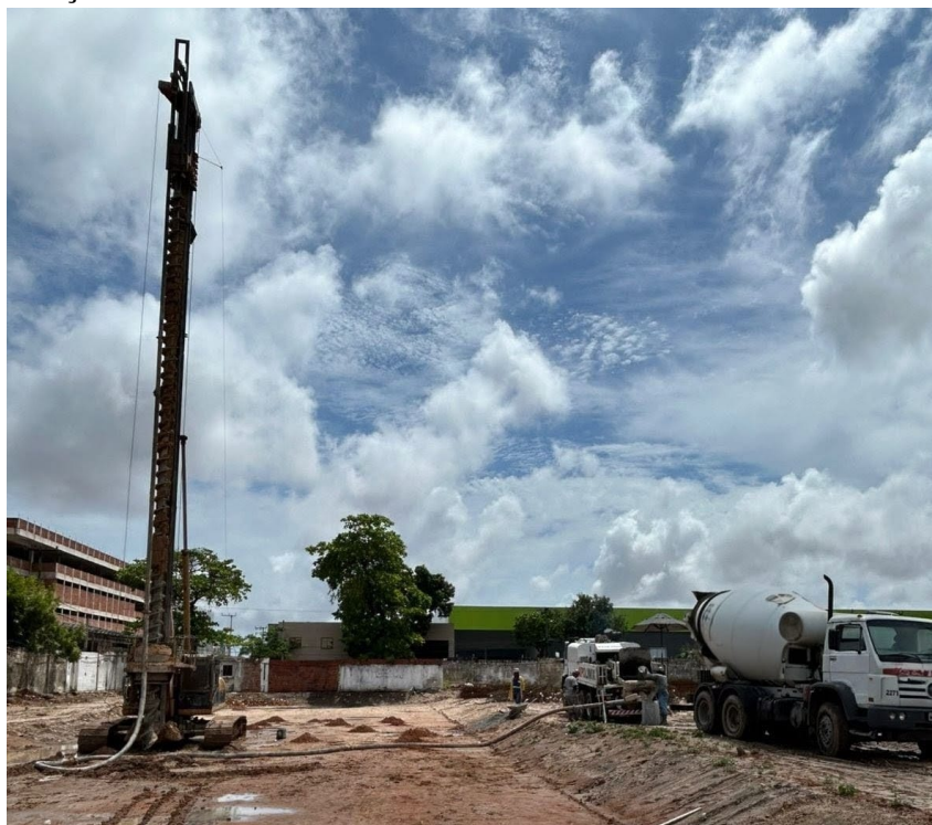
Figura 6 — Execução Estaca Hélice Contínua. Monitorada.
