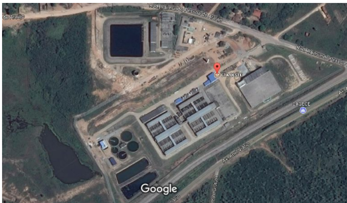
Figura 9- Localização da estação de tratamento de água
