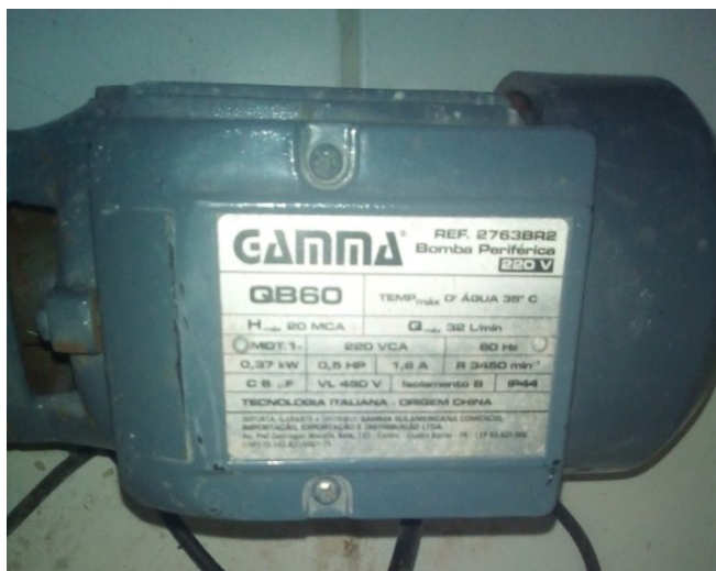
Figura 13- Bomba de pressurização da dupla filtração modificada
