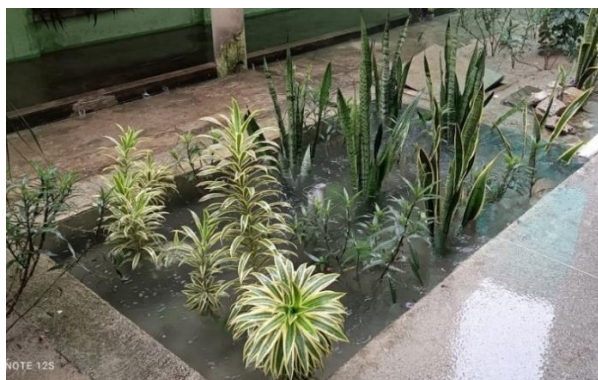
Figura 21 — Célula de biorretenção durante extravasamento no Evento 50 em 28/05/2024. P_{TOTAL}=128,60 mm/h; I_{MED}=9,77 mm/h; t=3040 min. e t.=790 min.)
