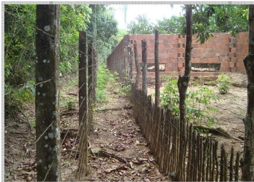
Figura 4 - Cerca de delimitação do PARNA Ubaíjara (CE no espaço correspondente à primeira demarcação (à esquerda) e cerca e muro de proprietário na área ampliada. Foto: Iara Oliveira, 2011. 3
