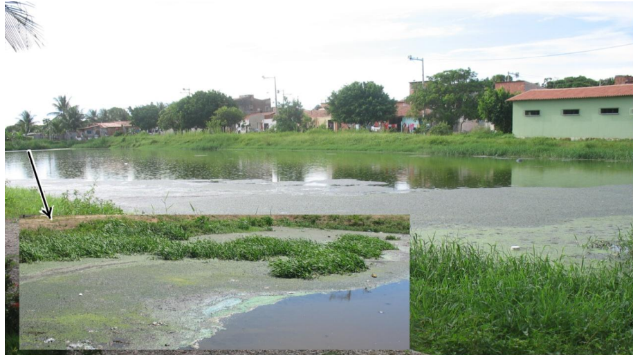
Figura 2 - Lagoa facultativa com acúmulo de lodo e em parte coberta por capim.
