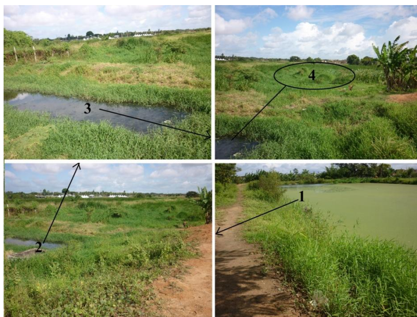
Figura 4 - Seqüência do lançamento do esgoto doméstico tratado: 1 - saída das lagoas de estabilização, 2 - vertedouro, 3 - vala no solo e 4 - solo da fazenda do Riacho Uirapuru.
