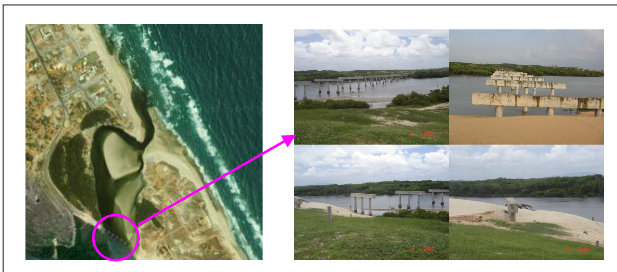
Figura 17. Pilares da ponte do Rio Cocó.
