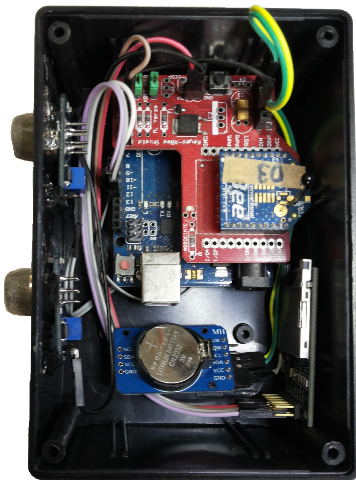
Figura 18: Protótipo dos Nós Sensores em caixas de pvc.
