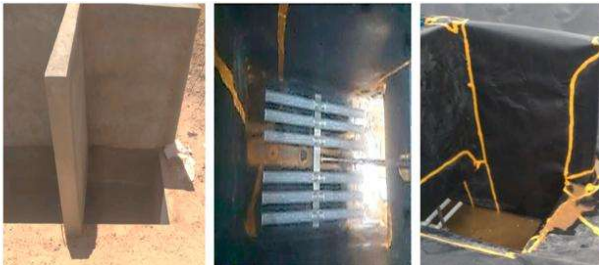
Figura 12 - Fotos do tanque Oxylag com difusão de ar.
