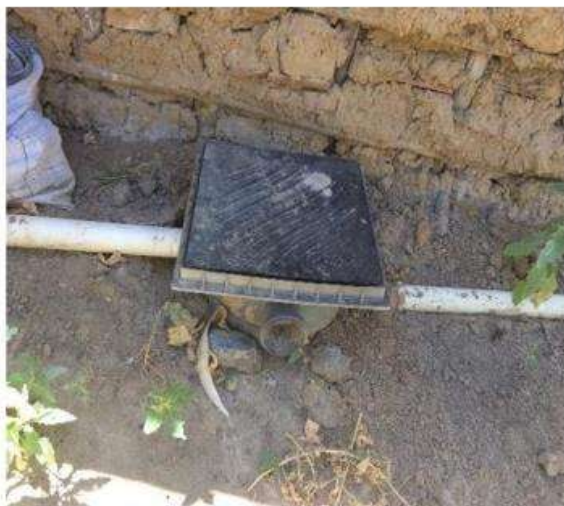
Figura 56 - Componentes do sistema de reúso familiar com filtro biológico
