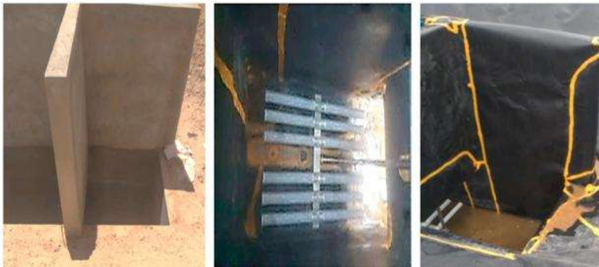
Figura 58 - Fotos do tanque Oxylag com difusão de ar
