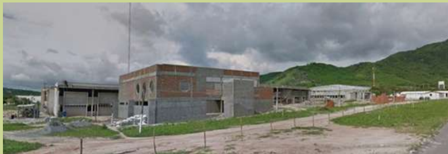
Prédio em construção
