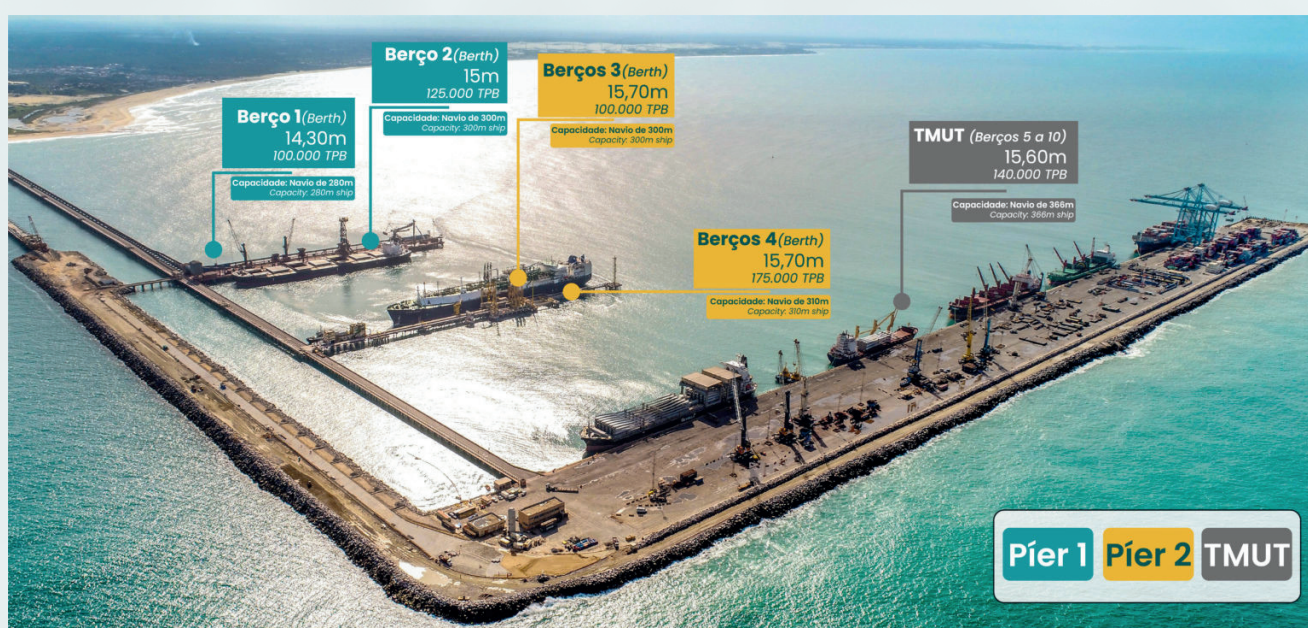
Figura 3 – Píeres de Operação de Navios do TPP
