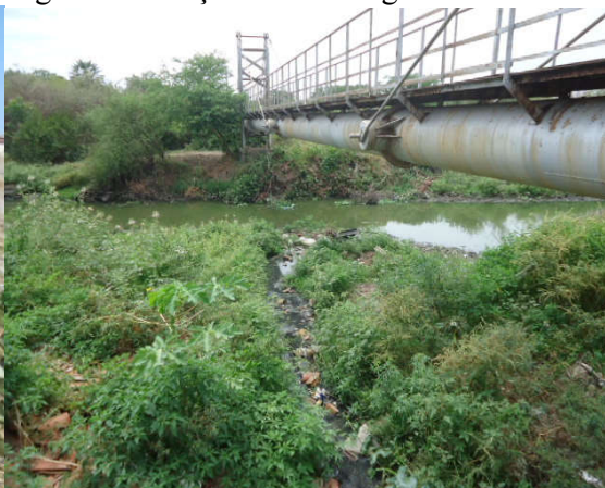
Figura 6 - Lançamento de esgoto.
