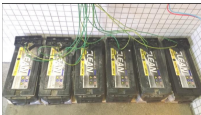
Figura 102 – Banco de baterias do subsistema FV2
