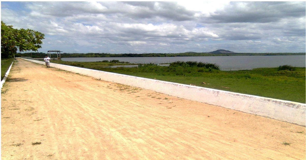
Figura 5 – Açude Gavião, no Município de Itaitinga-CE.
