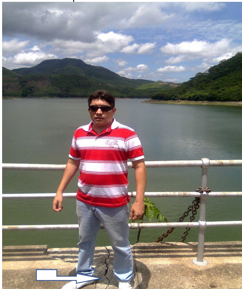
Figura 3 – Falha ou rachadura na parede do açude Acarape do Meio.
