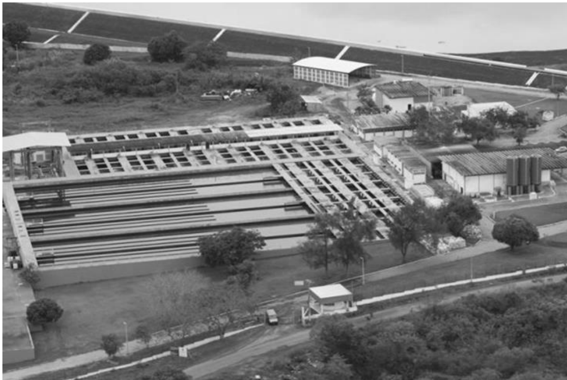
Figura 13 – Foto aérea da ETA do Açude Gavião.
