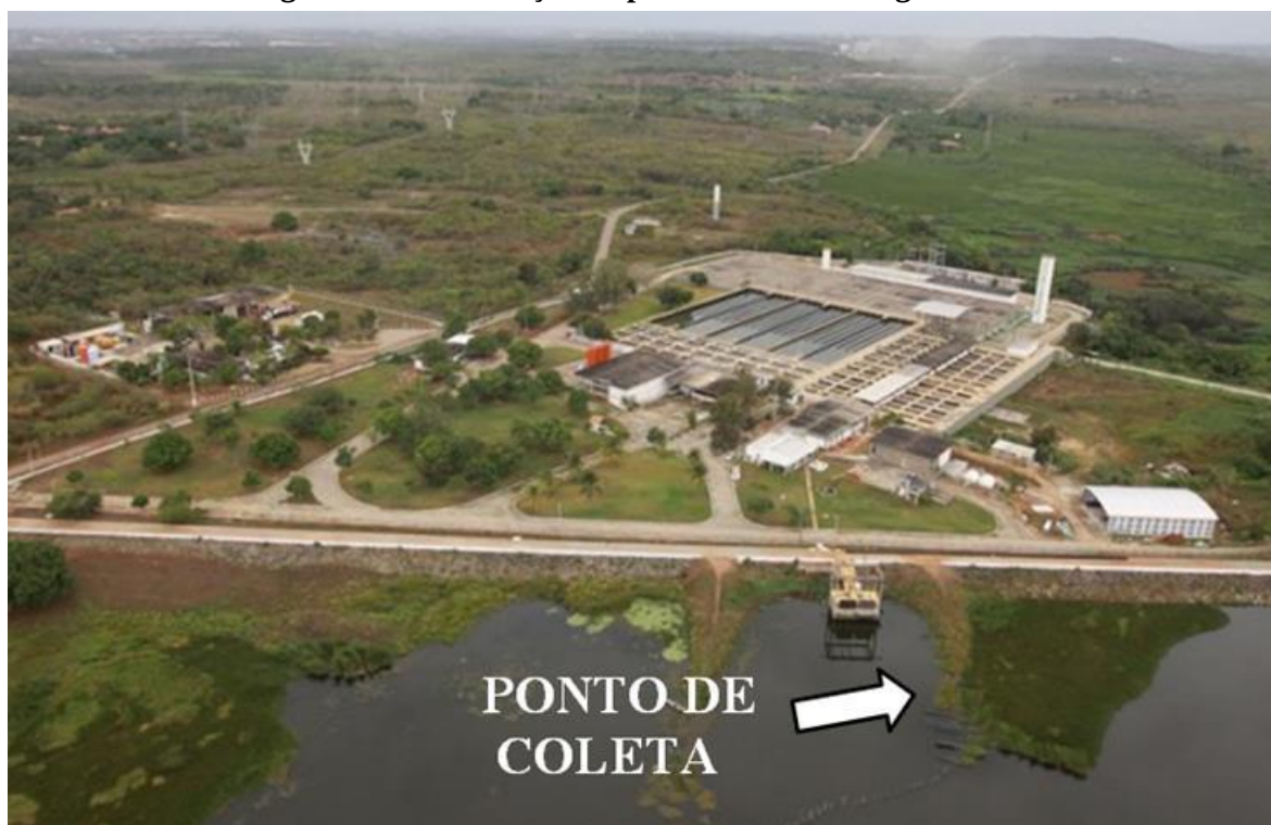
Figura 15 – Localização do ponto de coleta de água bruta.
