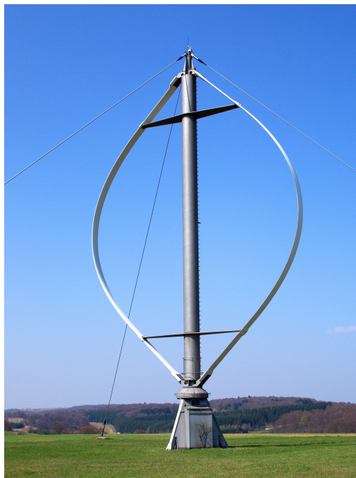
Figura 2 – Turbina eólica de eixo vertical do tipo Darrieus.
