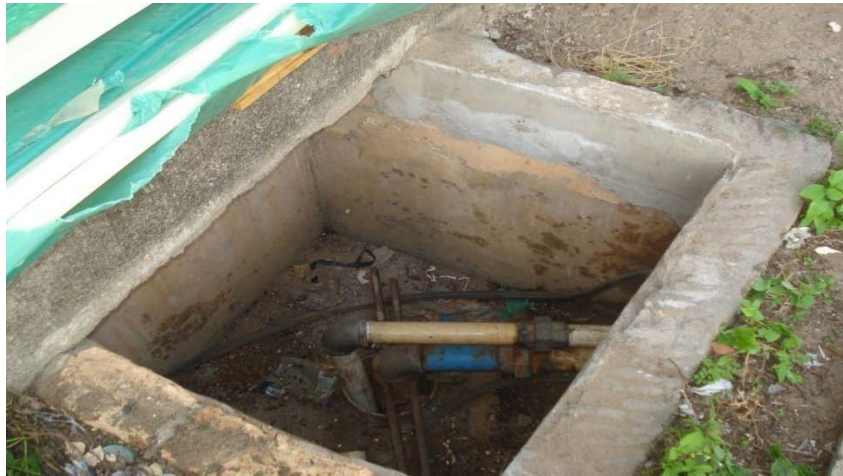
Figura 20 – Poço 1 na área do Metrofor que foi bombeado para a determinação da condutividade hidráulica do aquífero.
