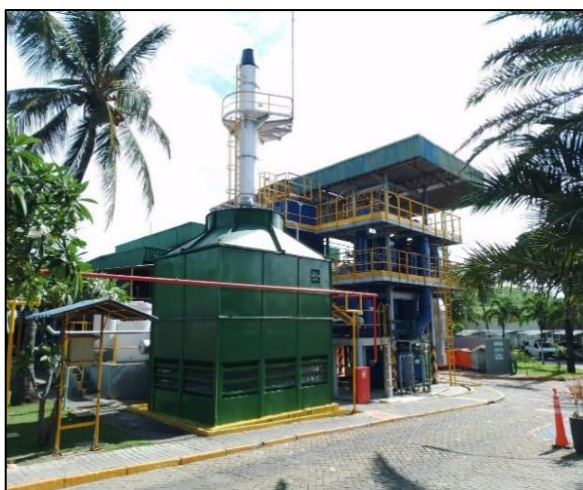
Figura 2 - Vista geral do incinerador de Fortaleza-CE
