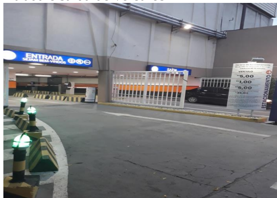
Figura 16- Aberturas de ventilação natural na Entrada e saída de veículos
