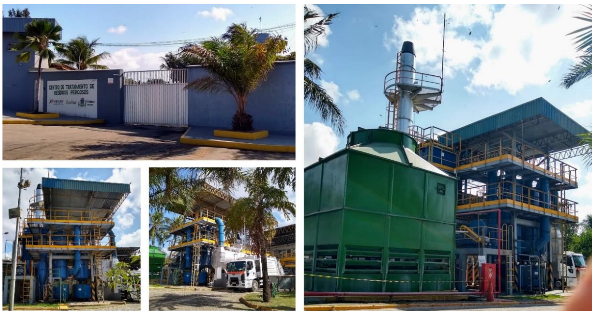
Figura 2 - Vistas parciais do incinerador de Fortaleza/CE
