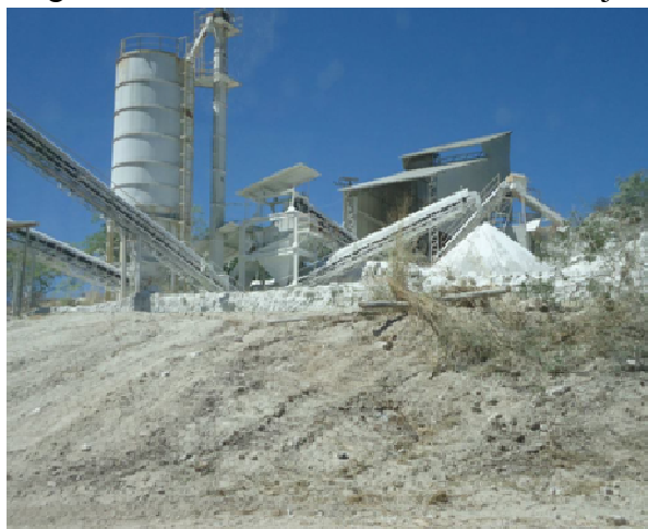
Figura 4 – Setor de britagem da Mina Pedra Branca visitada em julho de 2012.
