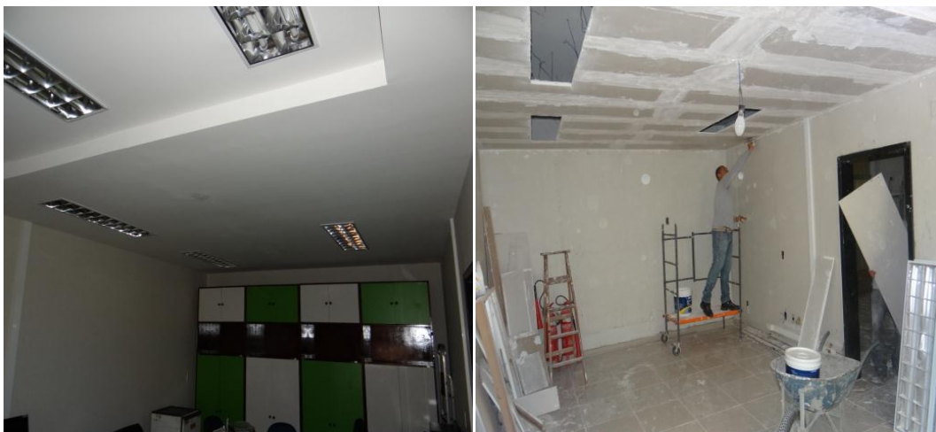
Figura 17 – Placas de forro gesso e resíduos gerados durante a execução do forro.
