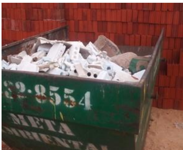
Figura 21–Container de coleta dos resíduos de gesso.
