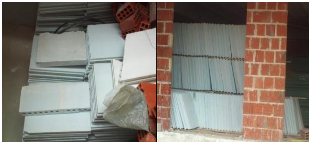
Figura 20 – Blocos de gesso armazenados em obra visitada em 2012.
