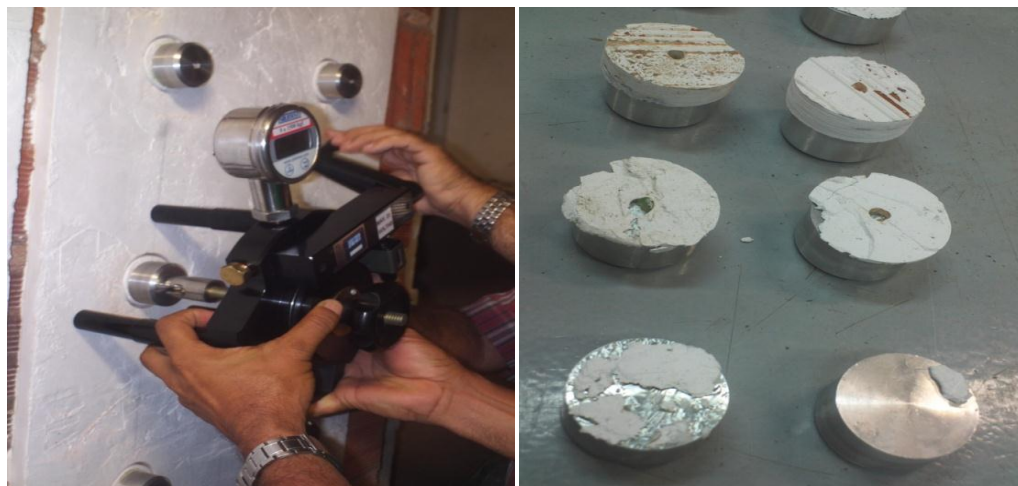
Figura 33 – Execução de ensaio de resistência de aderência à tração.
