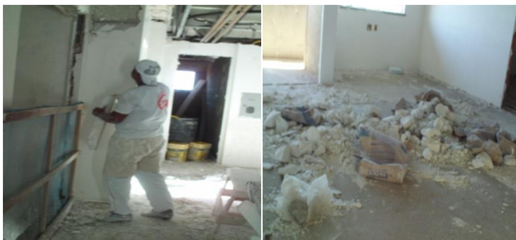
Figura 16 – Nivelamento da superfície e resíduos gerados na aplicação.
