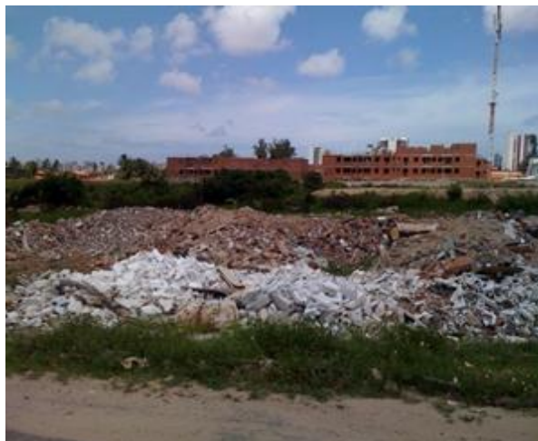
Figura 22 – Destinação inadequada de resíduo de RCD.
