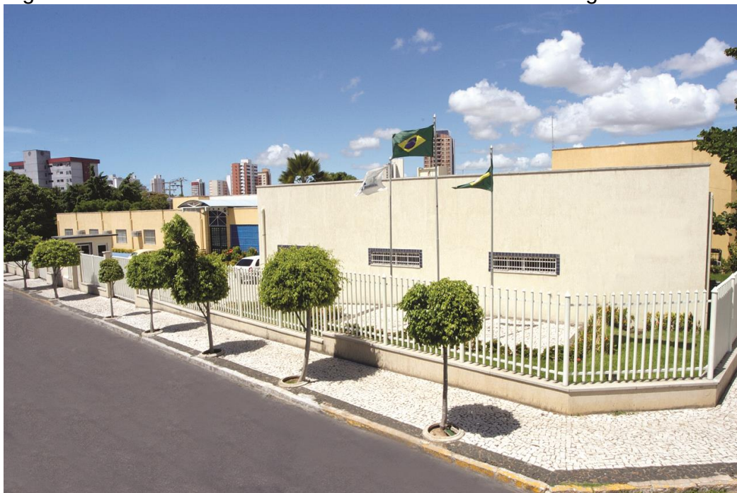
Figura 8 – Fachada do Instituto Centro de Ensino Tecnológico.
