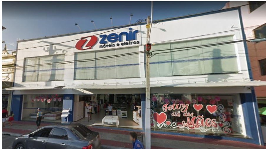
Figura 5 - Edificação em estudo na cidade de Sobral (CE)
