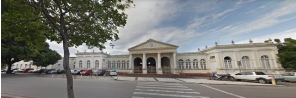
Figura 7 - Estação Ferroviária Dr João do Monte (CE)
