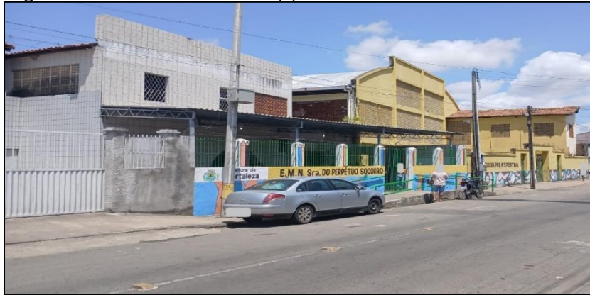
Figura 5 - Fachada da Escola (a)
