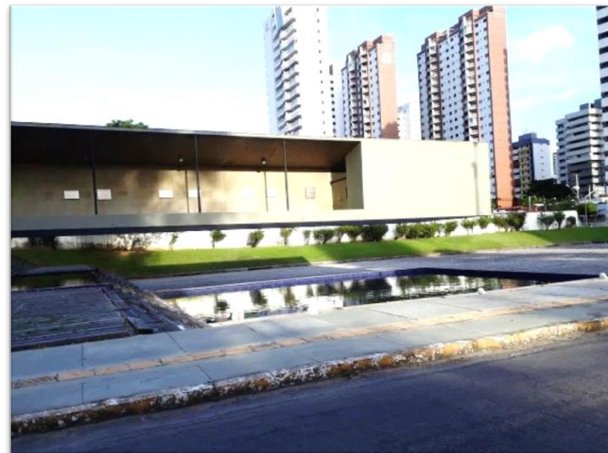
Figura 29 - Fachada principal do Mausoleu. Fonte: Autora (2018).
