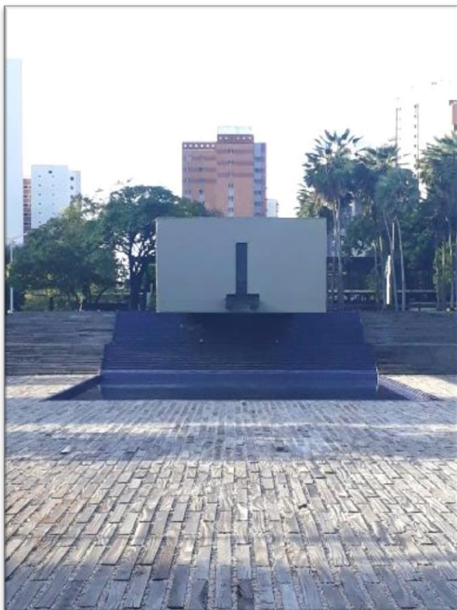
Figura 28 - Fachada lateral do Mausoleu. Fonte: Autora (2018).
