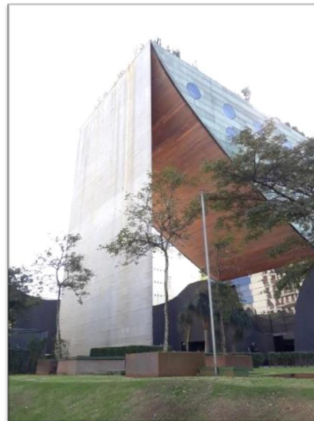
Figura 31 - Empena de concreto que sustenta o edifício. Fonte: Autora (2018).
