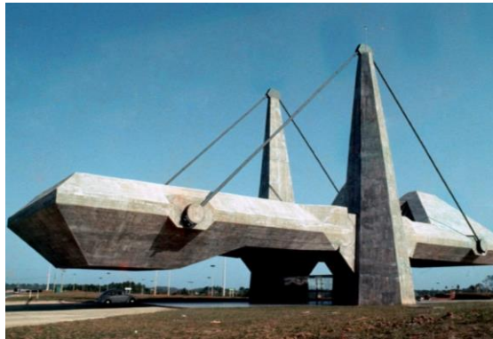
Figura 7 - Centro de Exposições do Centro Administrativo da Bahia
