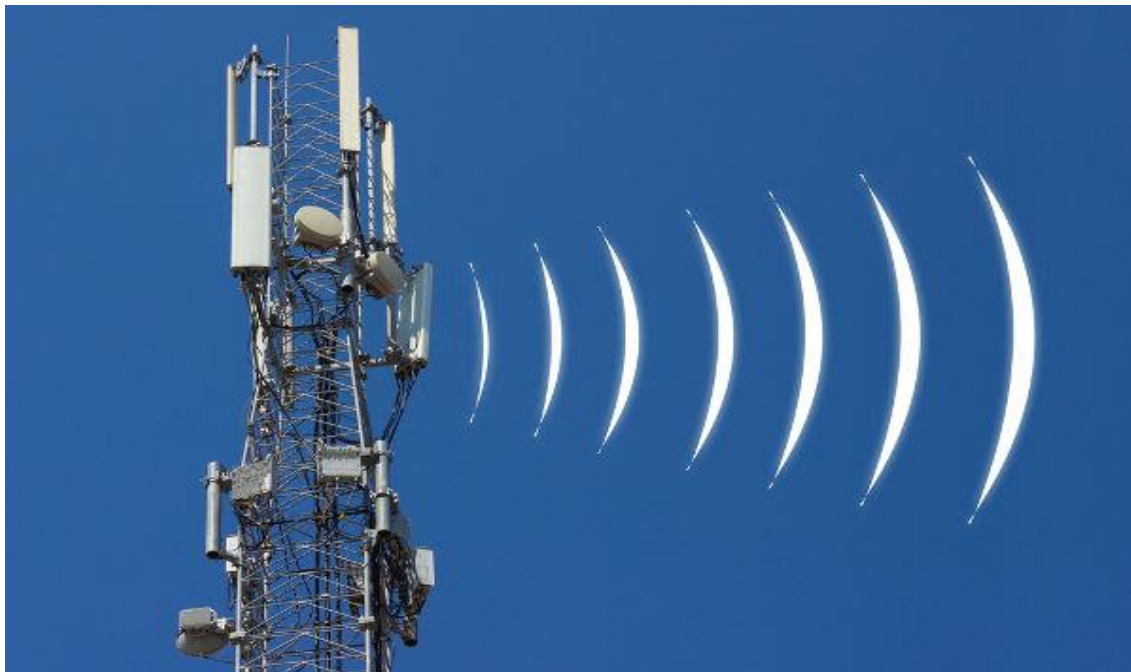
Figura 1 – Torre com antenas TX e RX de sinais para TV, rádio e telefonia móvel
