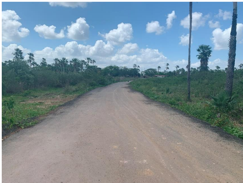
Figura 9 – Estrada vicinal beneficiada com RAP no Município de Caucaia-CE
