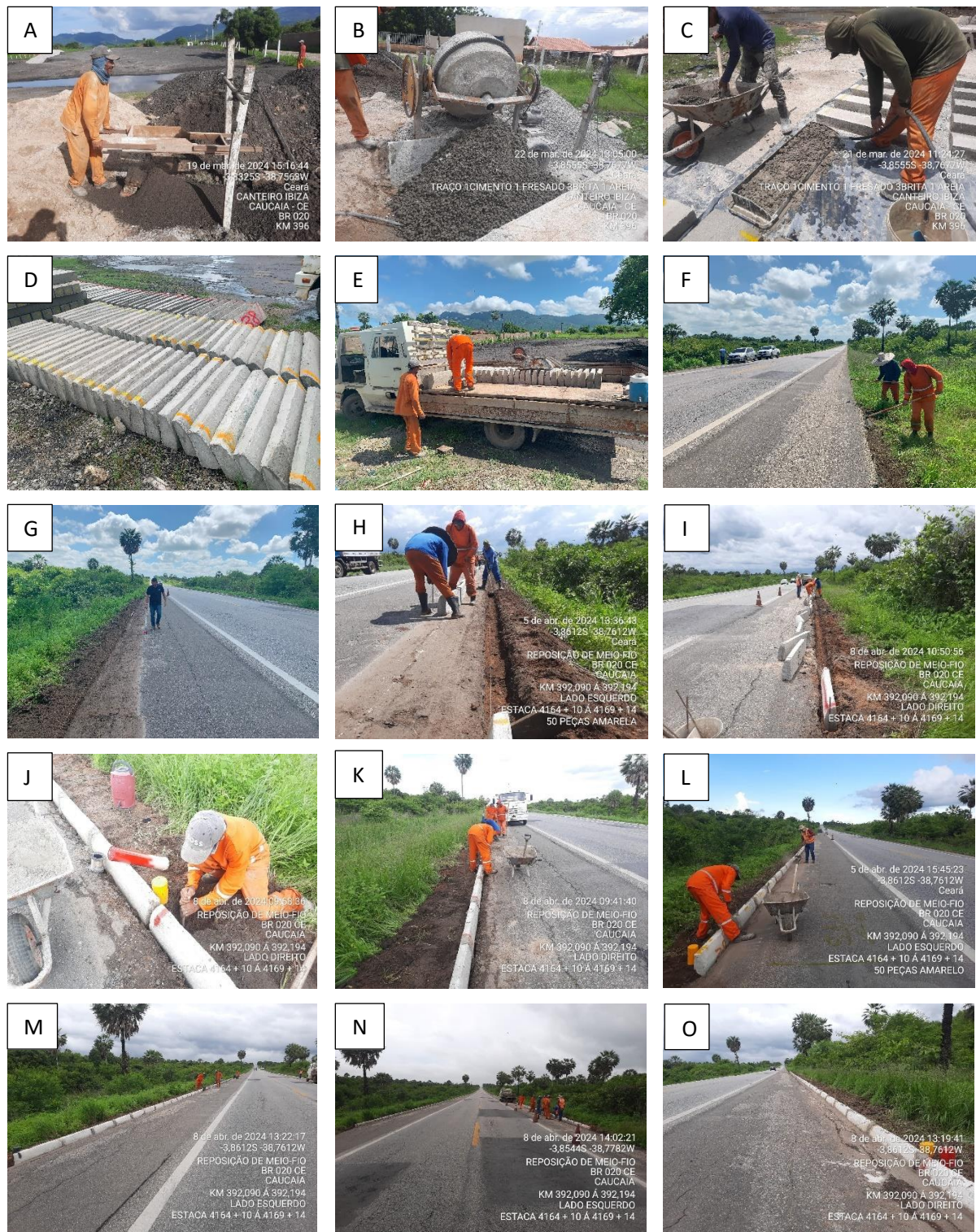
Figura 23 – Registro fotográfico da confecção do MFC 05 (com e sem RAP) e implantação na BR-020/CE
