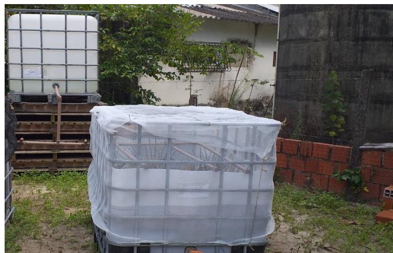
Figura 17 — Sistema de tratamento wetland construído.
