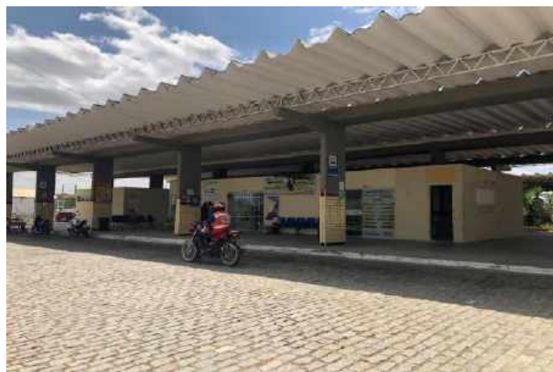
Figura 32: Vista interna – Terminal Rodoviário Municipal
