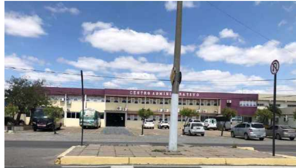
Figura 34: Vista externa – Centro Administrativo Municipal
