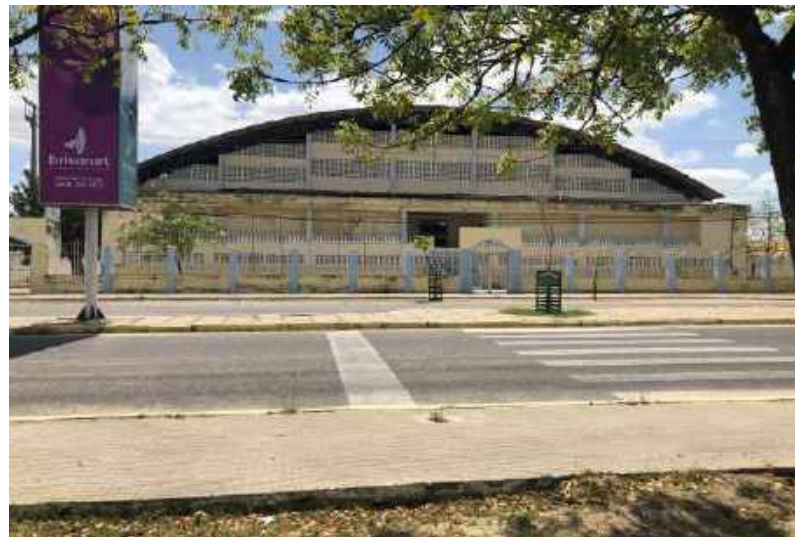
Figura 25: Vista fachada principal – Ginásio Municipal
