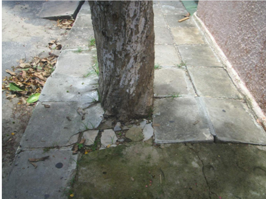
Figura 4.8 – Árvore sem área de crescimento, com raízes levantando a calçada (2007)
