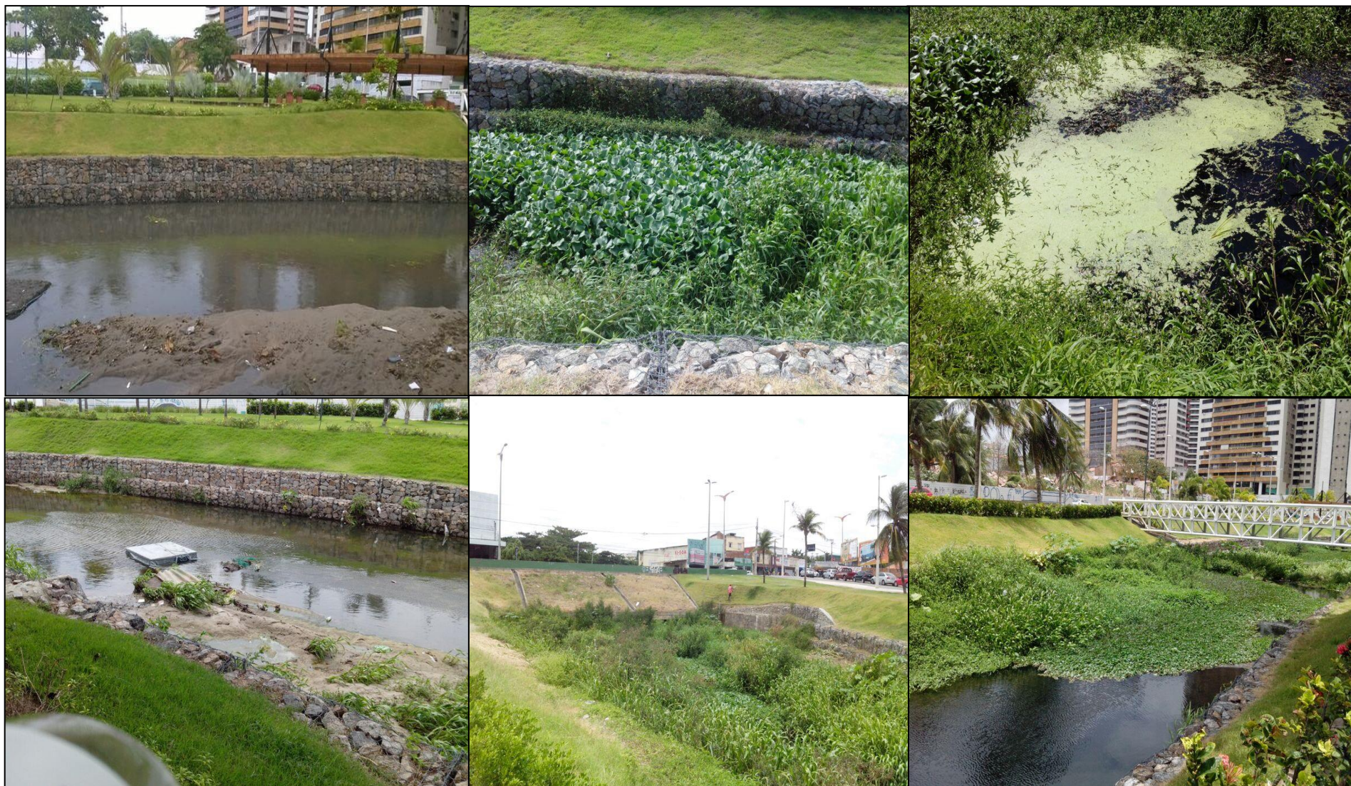
Assoreamento e eutrofização na foz do Riacho Maceió, Fortaleza-CE.
