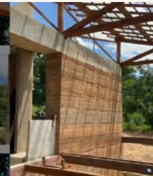
Parede de taipa de pilão em construção contemporânea.
