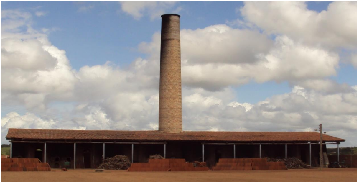
Figura 2- Processo de queima da cerâmica- Fornos
