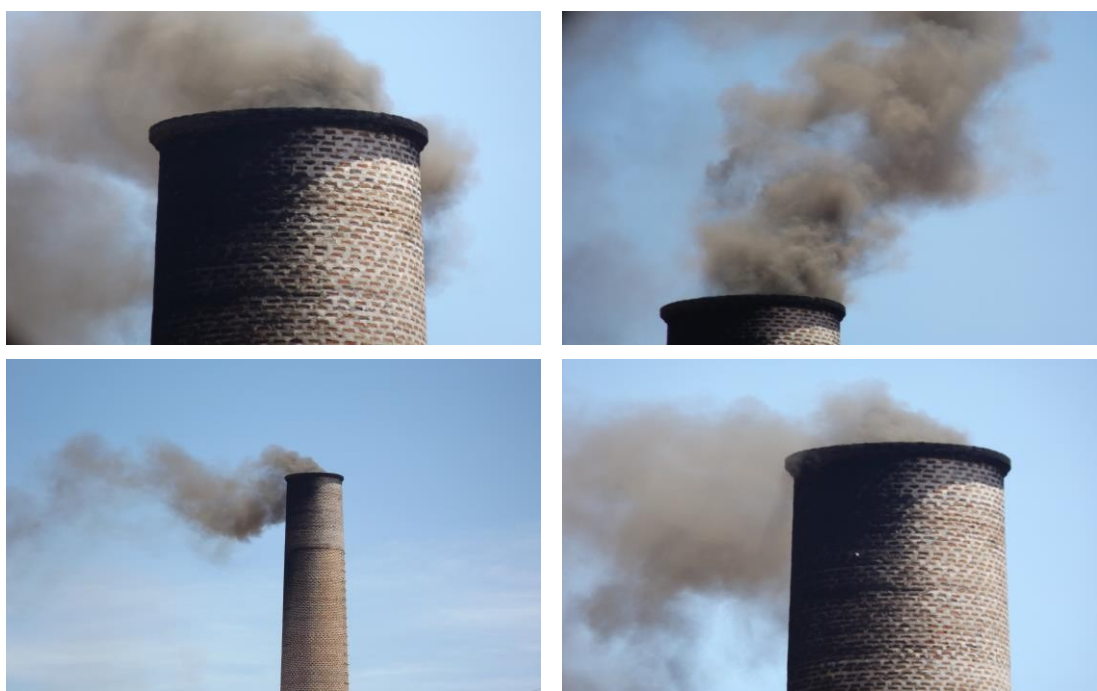
Figura 21 – Imagem das chaminés na fase de pré-aquecimento dos fornos
