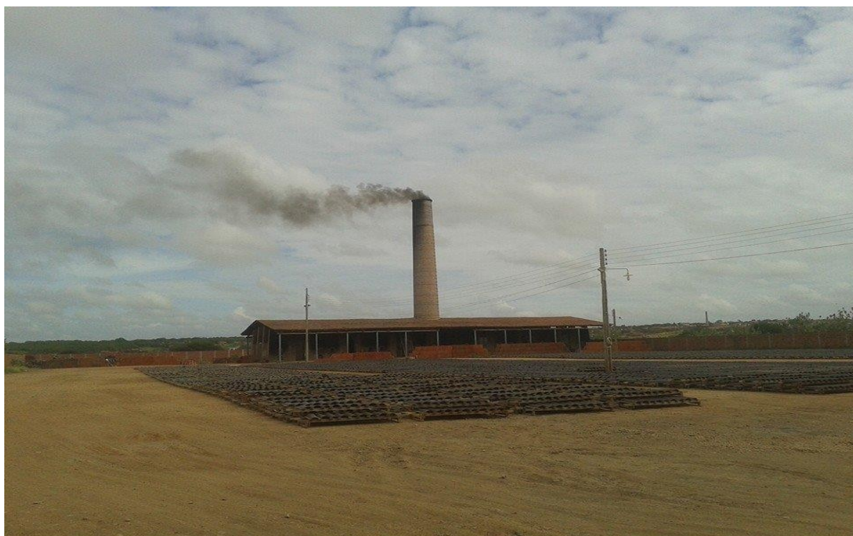
Figura 22 – Imagem da chaminé considerando a direção Leste dos ventos
