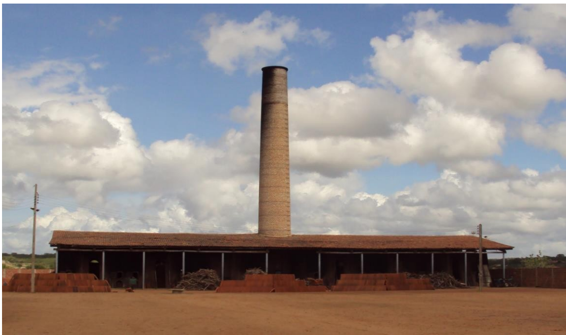
Figura 7 - Foto do forno tipo hoffmann
