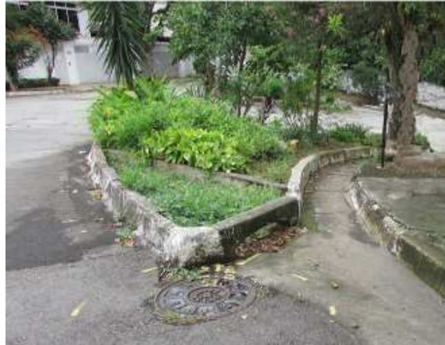
Figura 2 — Célula de biorretenção localizada na Vila Jataí, cidade de São Paulo (SP)
