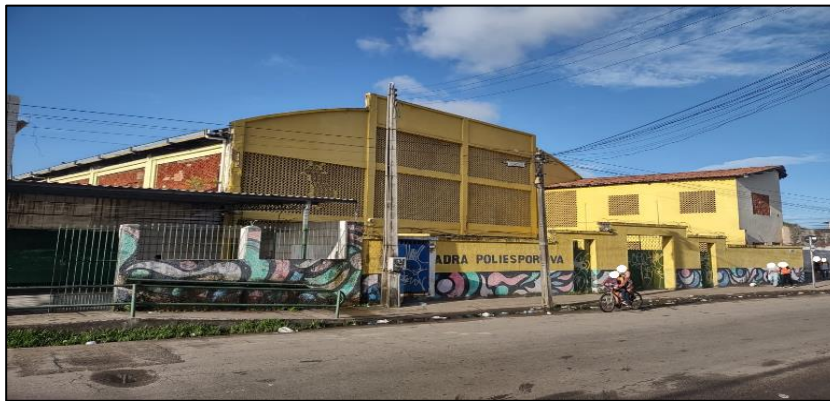
Figura 6 - Fachada da Escola (b)
