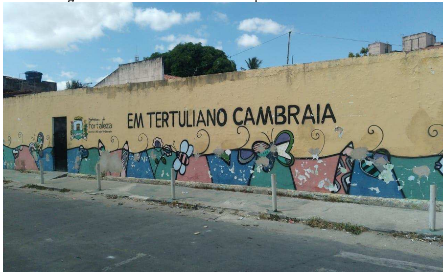
Figura 1 – Fachada da Escola Municipal Tertuliano Cambraia.
