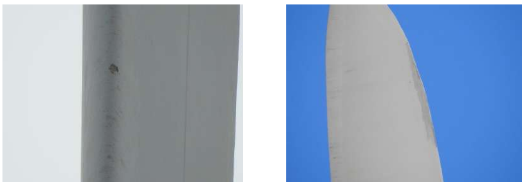
Figura 8 – Exemplos de danos de pintura
