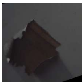
(a) Dano de descarga classificado corretamente
