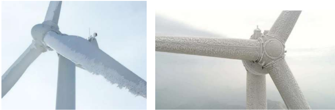
Figura 10 – Exemplos de danos por gelo
