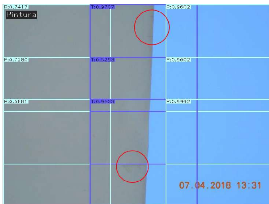
Figura 40 – Imagem original de trinca classificada incorretamente como dano de pintura. Com círculos vermelhos indicando as trincas existentes
