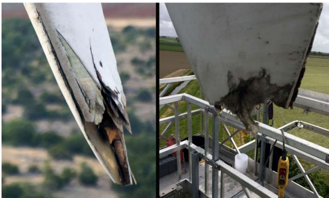
Figura 4 – Dano em uma pá eólica causado por uma descarga atmosférica
