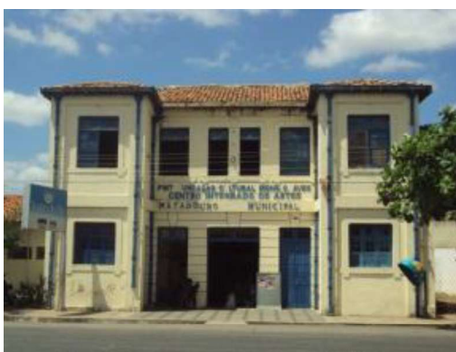
Figura 11 – CIARTE 18 - antiga fachada do Teatro do Boi, no bairro Matadouro, em Teresina/PI
