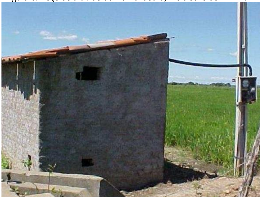
Figura 6: Poço do aluvião do rio Banabuiú, no trecho do PIMN.
