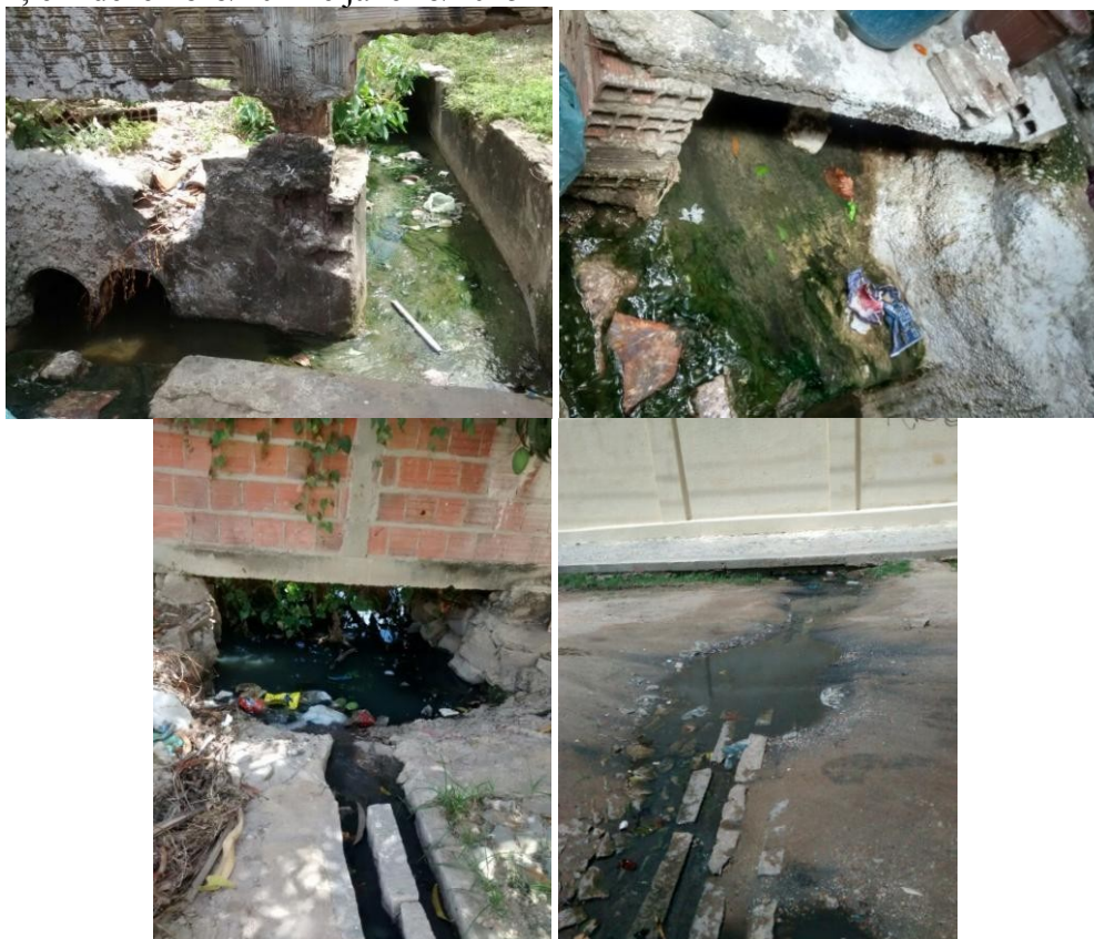
Figura 36 – Mosaico de fotos ilustrando os esgotos dispostos a céu aberto na ARIE do Sítio Curió/CE, em dezembro/2014 e janeiro/2015
