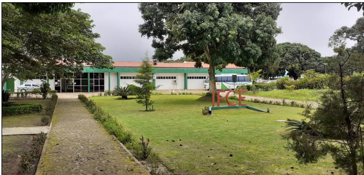
Fotografia 5 — Fachada do IFCE campus Ubajara
