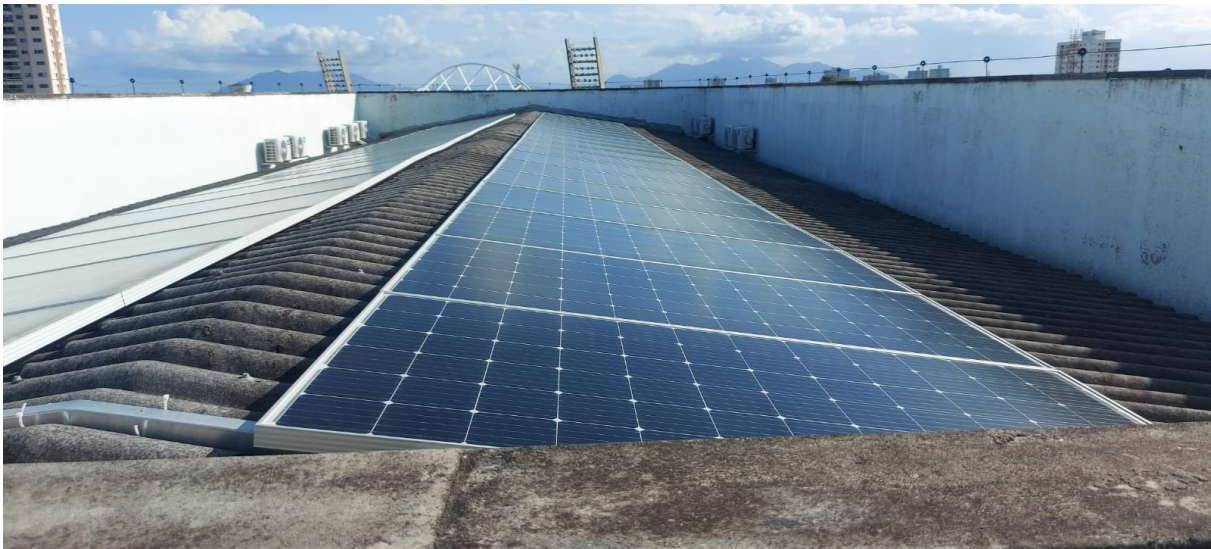
Figura 15 – Telhado IFCE, Campus Fortaleza
