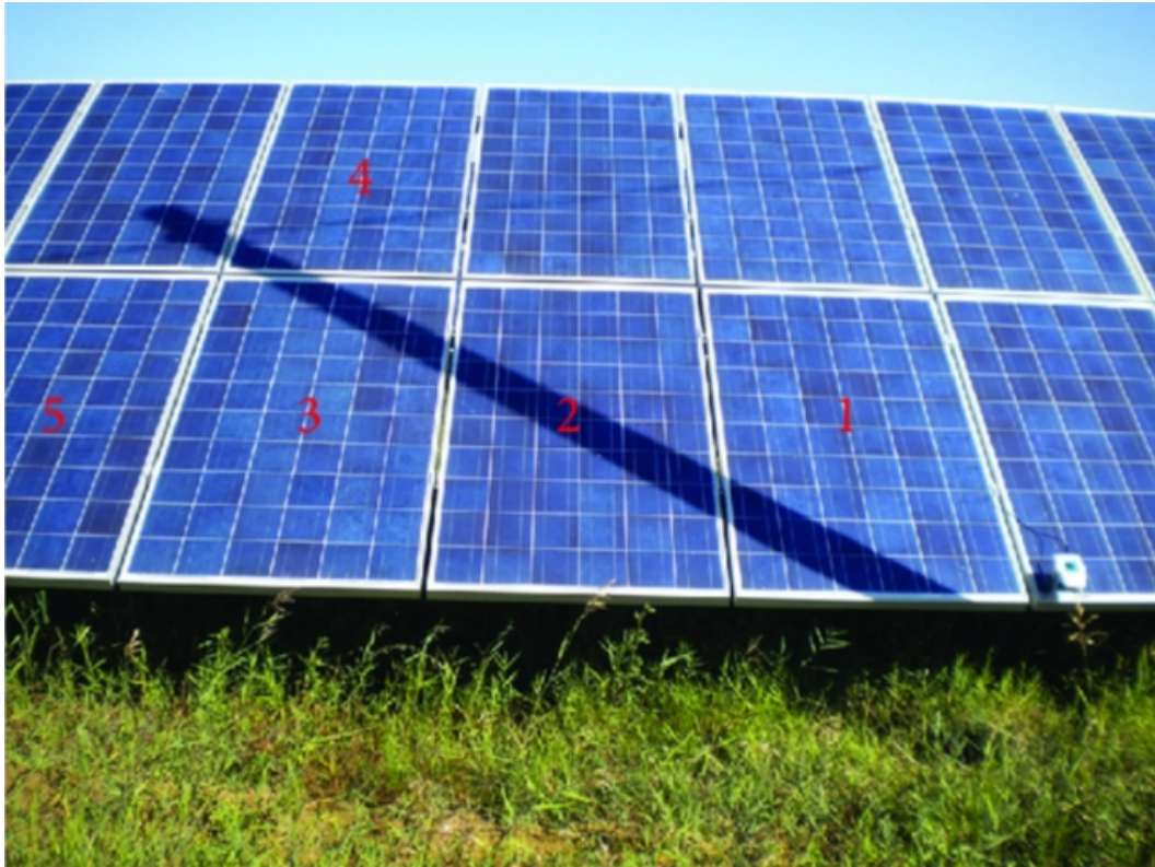
Figura 6 – Exemplo de painéis solares parcialmente sombreados
