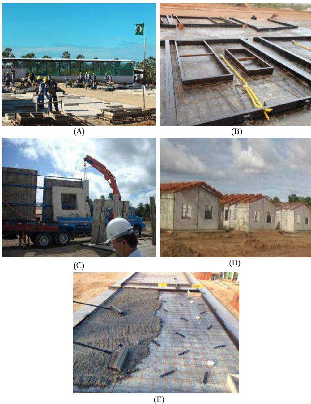
Figura 4 – Detalhes do painel DATec 021-A: (A) Pista de produção dos painéis; (B) Detalhes das fôrmas metálicas dos painéis; (C) Içamento dos painéis com caminhão munck; (D) Posicionamento dos painéis sobre argamassa; (E) Detalhes dos preenchimentos do painel.
