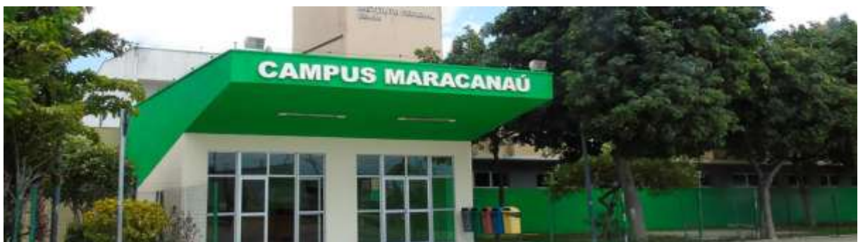
Figura 7 – Fachada do IFCE Maracanaú, 2024
