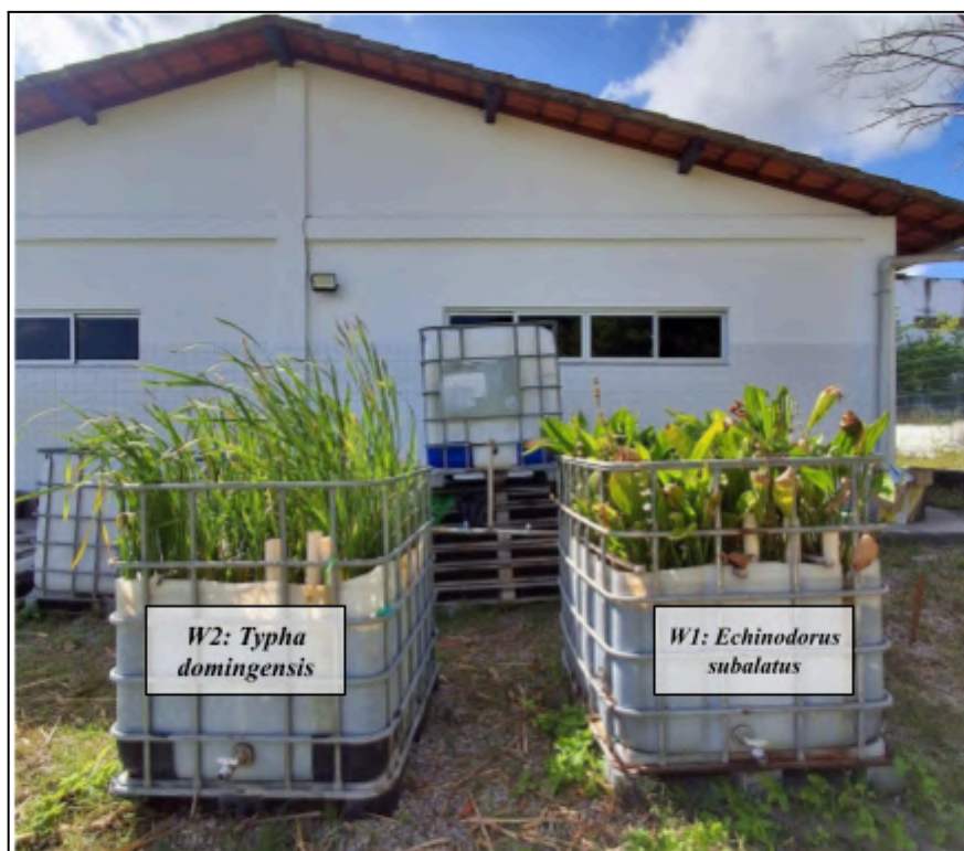
Figura 5 — Sistemas wetlands construídos para tratamento do efluente sintético utilizado no estudo.
