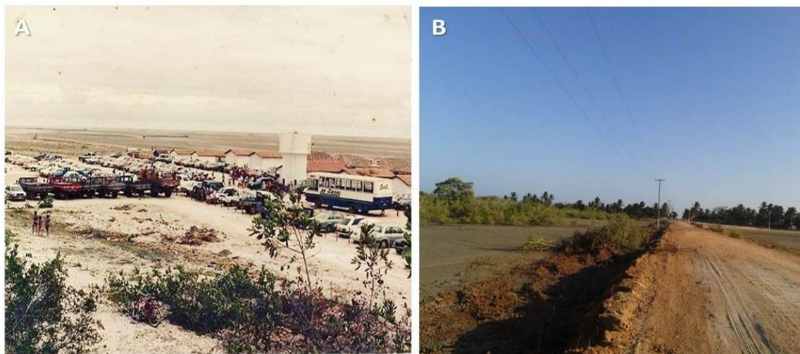
Figura 4 – Imagens das intervenções urbanas na região de Arpoeira-Acaraú/CE. (A) Barracas construídas pela Prefeitura Municipal de Acaraú em 1991, (B) Estrada da Praia de Arpoeiras durante as obras de asfaltamento em 2014.
