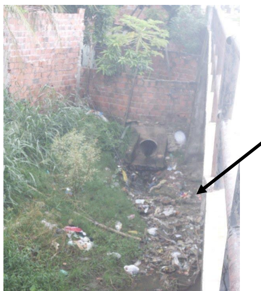
Figura 26 – Lançamento de esgoto por galeria pluvial no Ponto 1, localizado a montante do lixão do Jangurussu.
