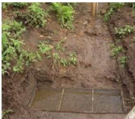
Figura 7 - Fosso coletor de sedimentos de arraste
