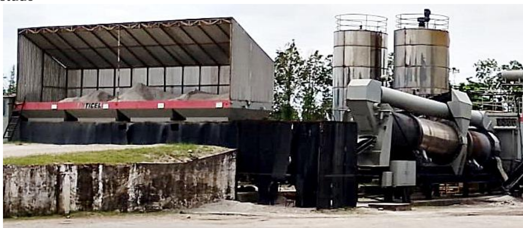
Figura 6 — Pátio industrial de processamento das misturas asfálticas na empresa em estudo
